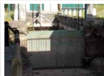
L'ouverture des vannes à Candol a totalement asséché le bief pour favoriser le cours d'eau principal.
